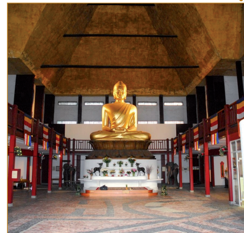
La Grande Pagode de Vincennes, siège de l'UBF, attend sa rénovation...
